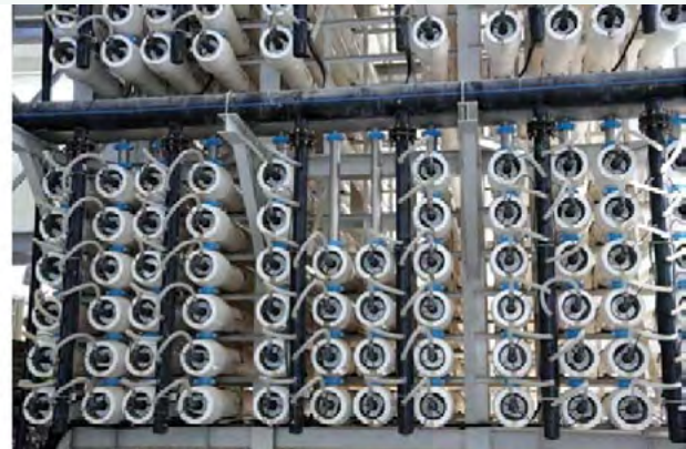
مع وجود خمس توربينات غازية واثنين من التوربينات البخارية، تبلغ سعة الطاقة المتعاقد عليها ٤٤٥ ميغاوات. مرفق تحلية مياه البحر عن طريق التناضح العكسي
