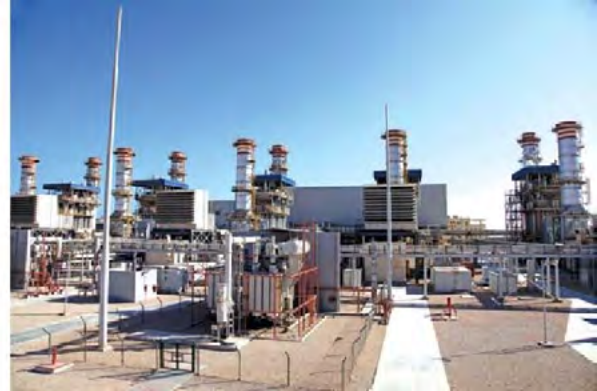
مع وجود خمس توربينات غازية واثنين من التوربينات البخارية، تبلغ سعة الطاقة المتعاقد عليها ٤٤٥ ميغاوات. مرفق تحلية مياه البحر عن طريق التناضح العكسي
