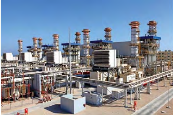
مع وجود خمس توربينات غازية واثنين من التوربينات البخارية، تبلغ سعة الطاقة المتعاقد عليها ٤٤٥ ميغاوات. مرفق تحلية مياه البحر عن طريق التناضح العكسي
